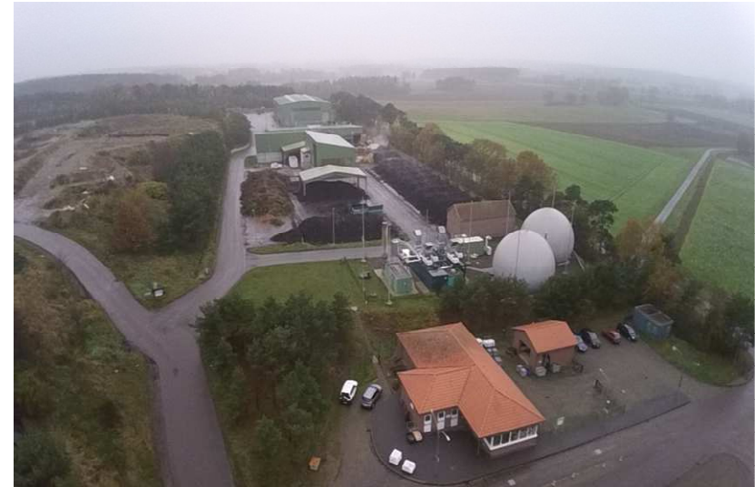
Eingangsbereich mit Entgasung und Kompostierung
