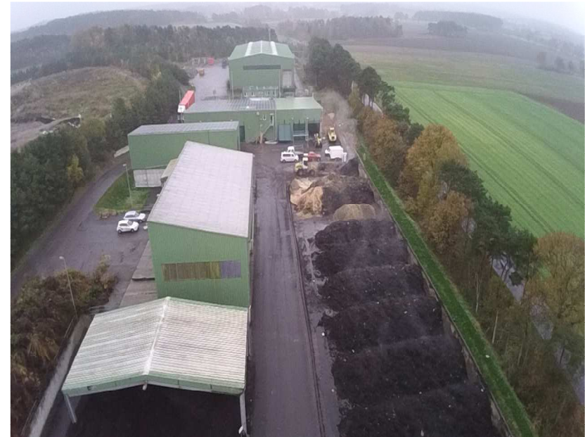
Nachrotte, Fermentergebäude, Umladeanlage
