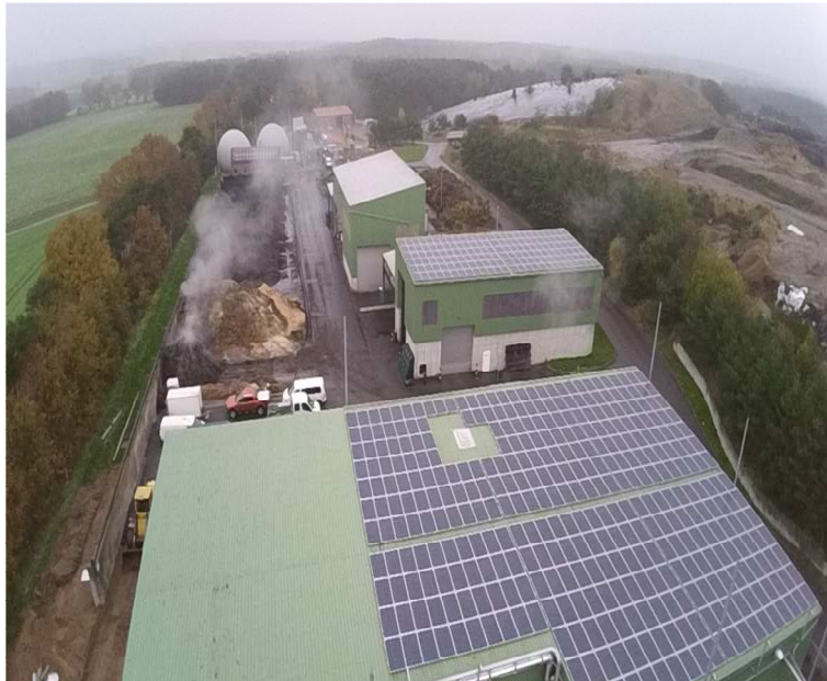
Blick auf Anlieferhalle und Nachrotte
