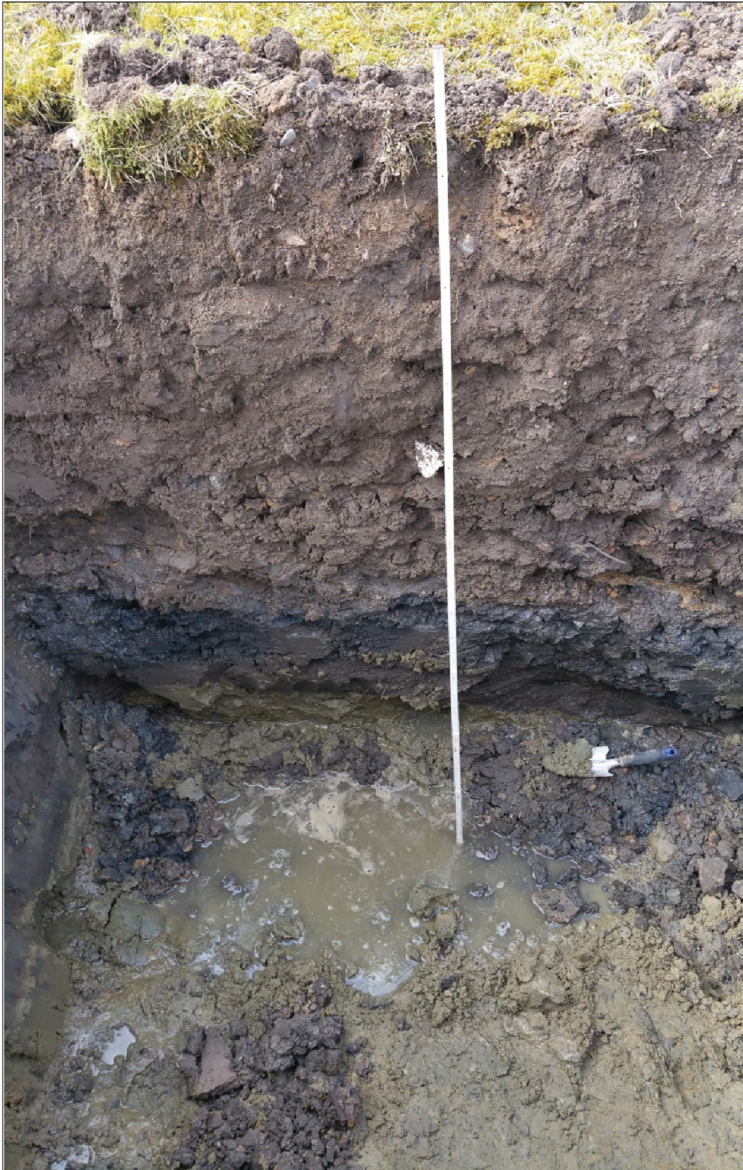
Foto 5: Schurf 5: Aufschüttung aus kiesigen, braunen Sanden mit Fremdbestandteilen, an der Sohle des Schurfes sammelt sich austretendes Schichtenwasser; Aufnahme datum 23.03.2018.
