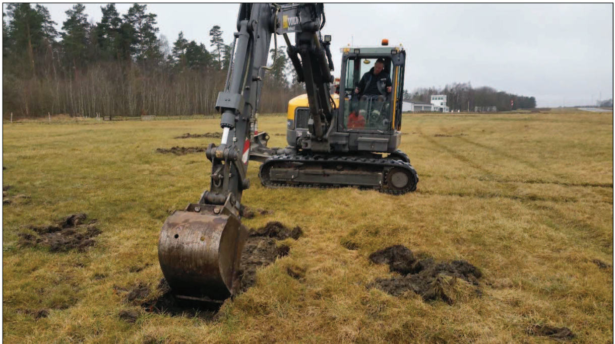
Foto 2: Anlegen des Schurfes 1 südlich des Wendepunktes für die Flugzeuge (erkennbar die Wühlspuren durch Wildschweine); Blickrichtung Westen, Aufnahme datum 23.03.2018.
