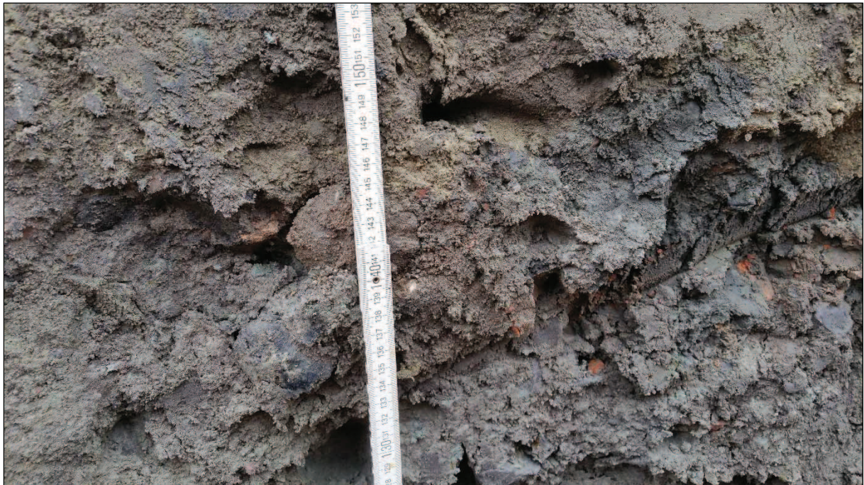
Foto 6: Schurf 6: Aufgefüllter Boden in einer Tiefe von 0,70 bis 0,95 m u. GOK (erkennbar Kiese und Ziegelreste sowie ein Asphaltbrocken links des Zollstocks); Aufnahmedatum 23.03.2018.
