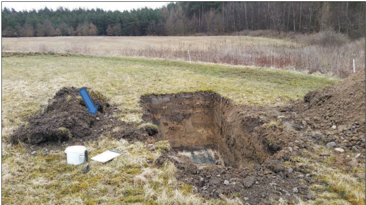
Foto 7: Schurf 7: Links ausgekoffter Oberboden mit Schottern (Pfeil) mit Grasnarbe; in dem Schurf wechselnd körnige, braune Sande (Auffüllung), ab 1,3 m Tiefe: Aueablagerungen (braun, gelbgrau und olivgrau); Blickrichtung Südosten, Aufnahmedatum 23.03.2018.
